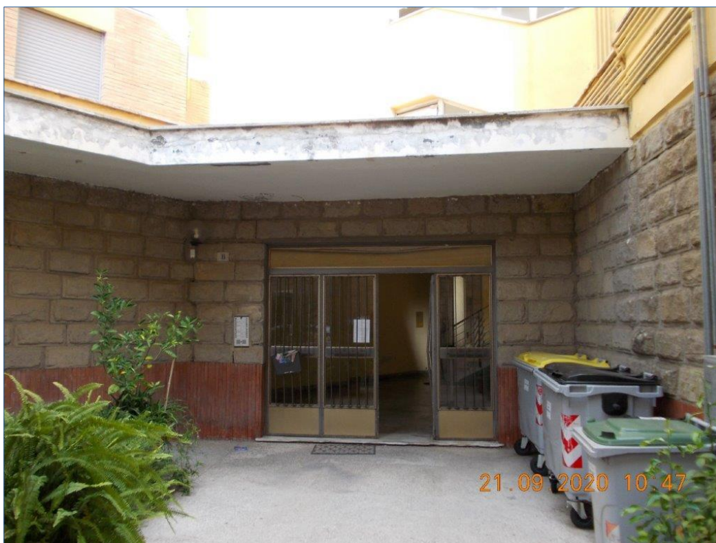
Foto 3. Ingresso edificio condominiale civico 4B
