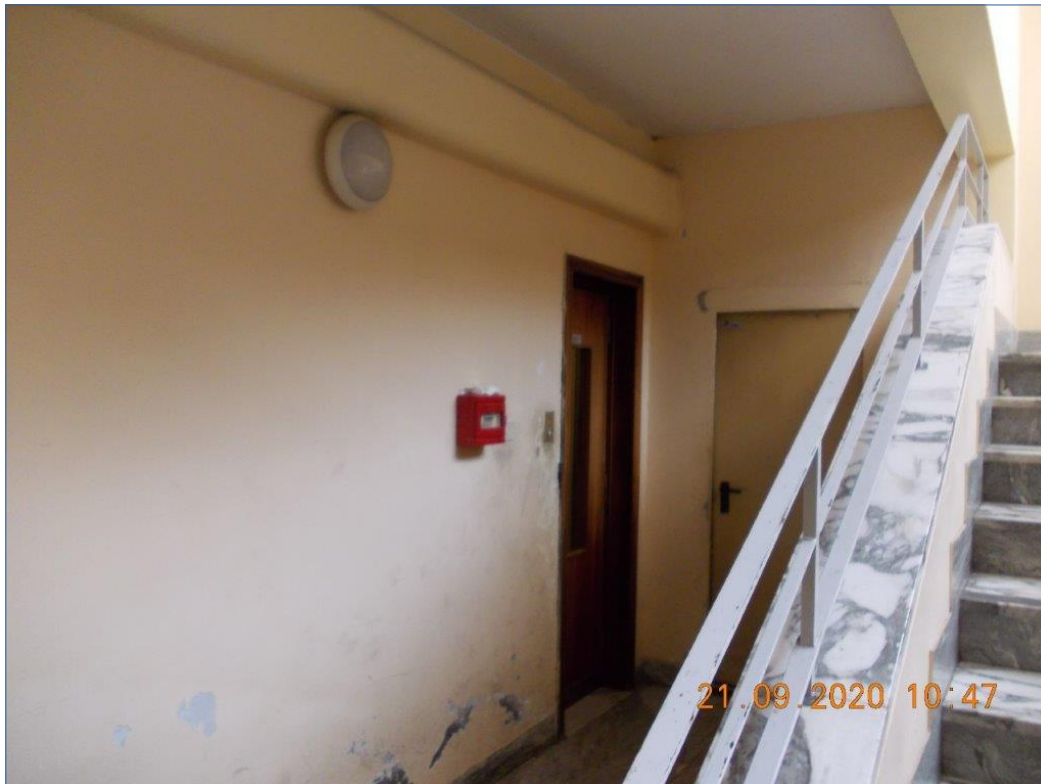
Foto 6. Vista vano ascensore
