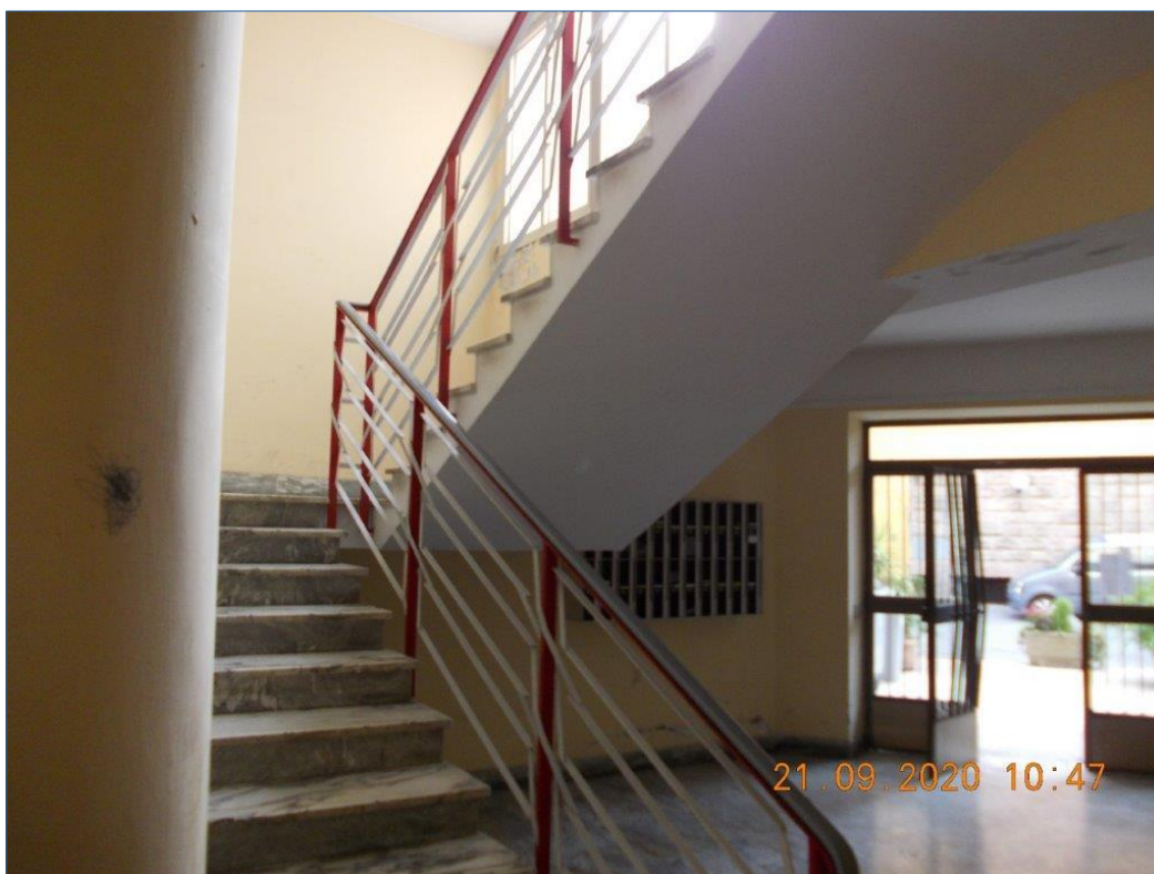
Foto 5. Vano scale condominiale
